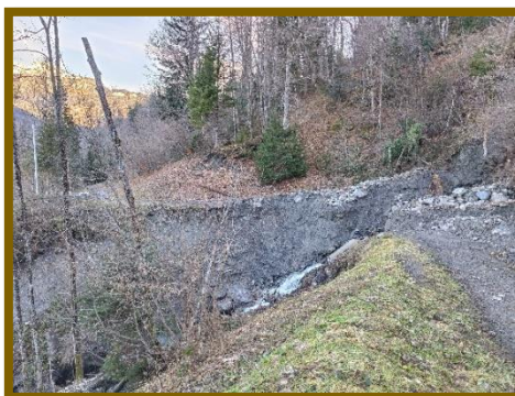
Chemin rural du Pont de Fer (partie haute)
